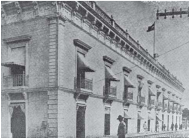
Palacio de los gobernadores generales, edificación colonial construida en el siglo XVIII en la calle Las Damas esquina Las Mercedes, y que sirvió de sede al gobierno militar norteamericano durante la ocupación a la República Dominicana de 1916 a 1924.
